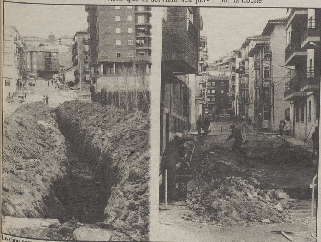
Las obras para canalización y posterior pavimentación han empezado por las calles Fray Gil y Rioja LUMBRERAS
