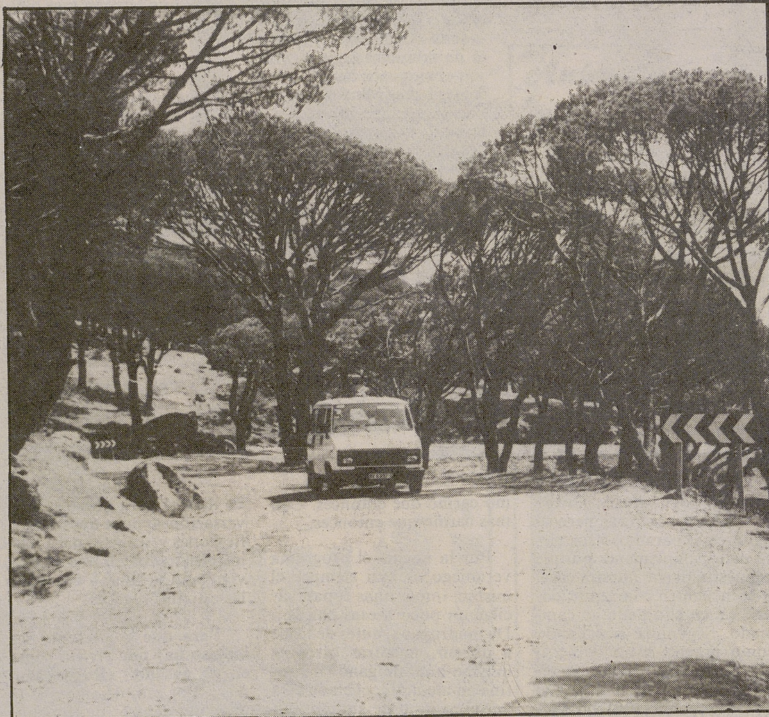
Carreteras en mal estado y curvas peligrosas empañan las buenas comunicaciones con El Hoyo de Pinares. TABASCO
