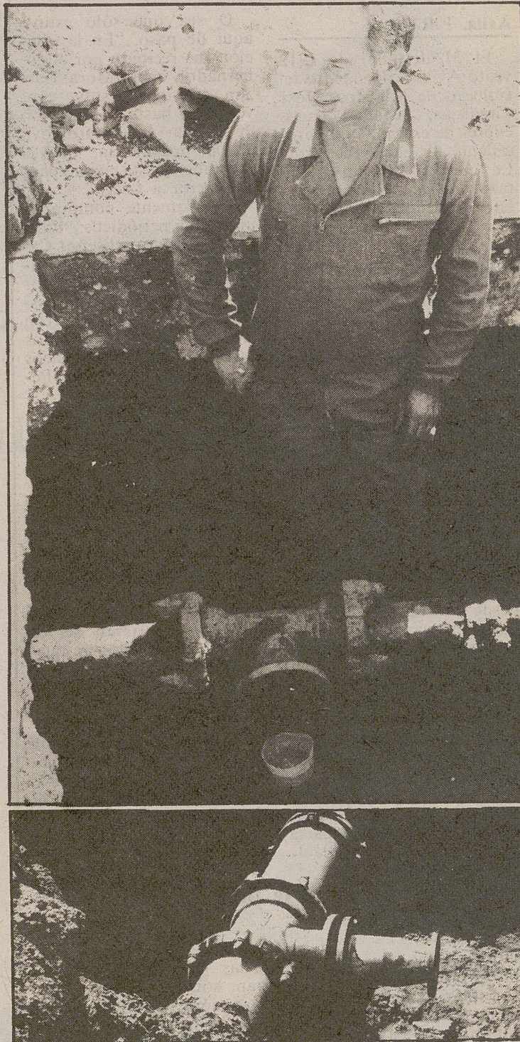
Reparación del registro en Avenida de la Juventud (foto superior) y arteria de Jesús del Gran Poder (foto inferior). VICTOR GONZALEZ
