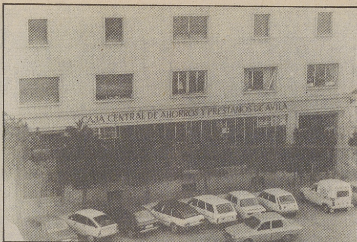
La fachada del edificio de la Caja Central, en plena Plaza de Santa Teresa LUMBRERAS
