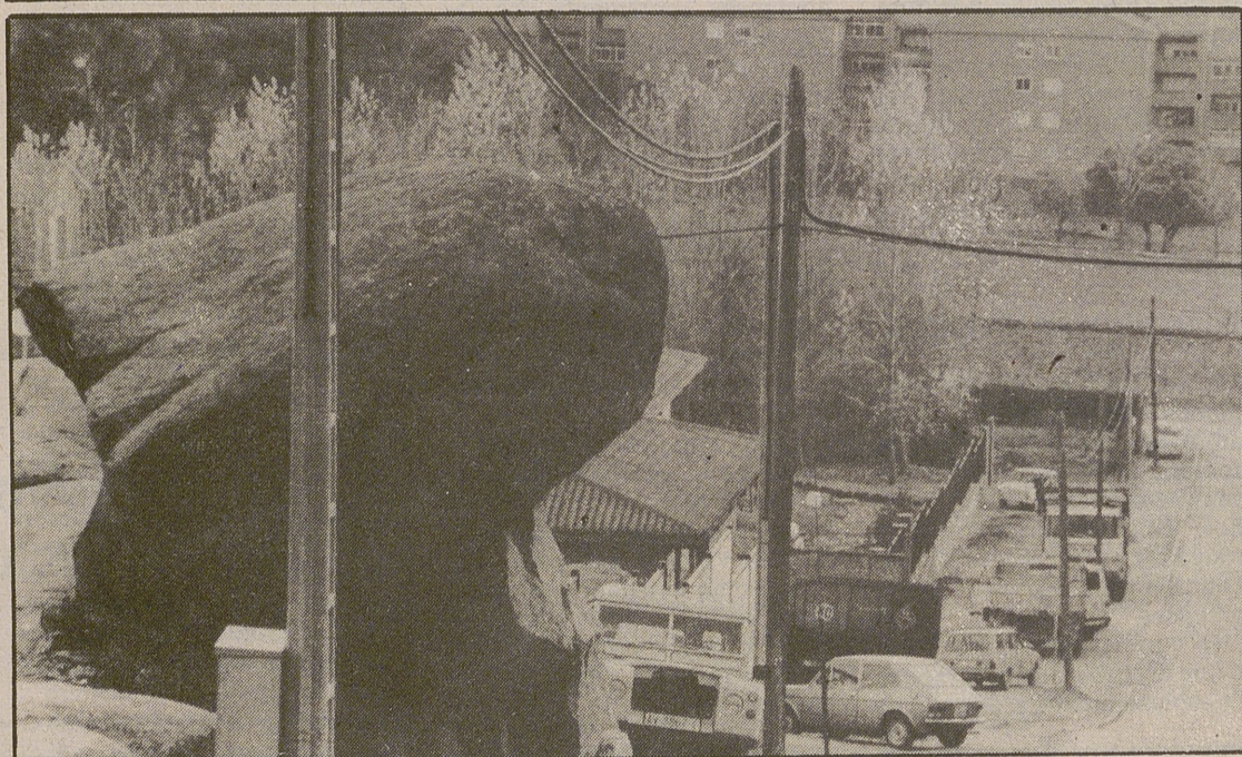
Por la posibilidad de tomar contacto con los cables eléctricos
