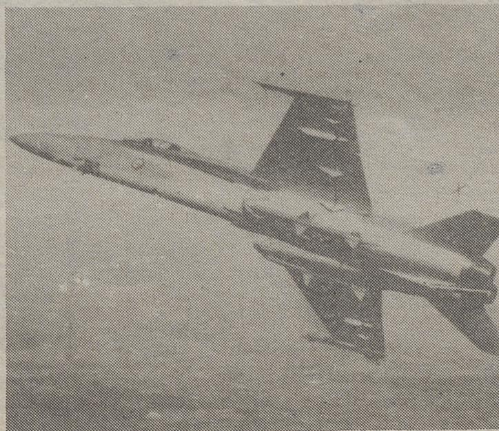
Ficha técnica: Avión monoplaza, bimotor, turboventilador. Longitud 17 metros. Altura, 4,66. Envergadura, 11,43. Superficie alar, 37,16 metros cuadrados. Peso bruto de despegue, 35.000 libras en misión de caza o de escolta.
