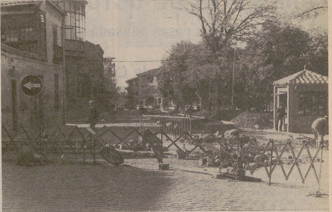
El Paseo del Dos de Mayo ha sido cortado al tránsito rodado en su totalidad (desde la calle Arévalo hasta la Avenida de Portugal), debido a las obras de ampliación de la calzada, que están llevándose ya a cabo. Dicha ampliación se hace para mantener la alineación con la calle Arévalo, y supone el sacrificio de unos metros cuadrados de parque, pertenecientes al jardín del Recreo. (Foto: LUMBRERAS).
