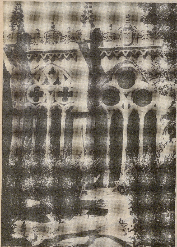
Claustro de la Catedral: a finales de este mes puede estar restaurado.
