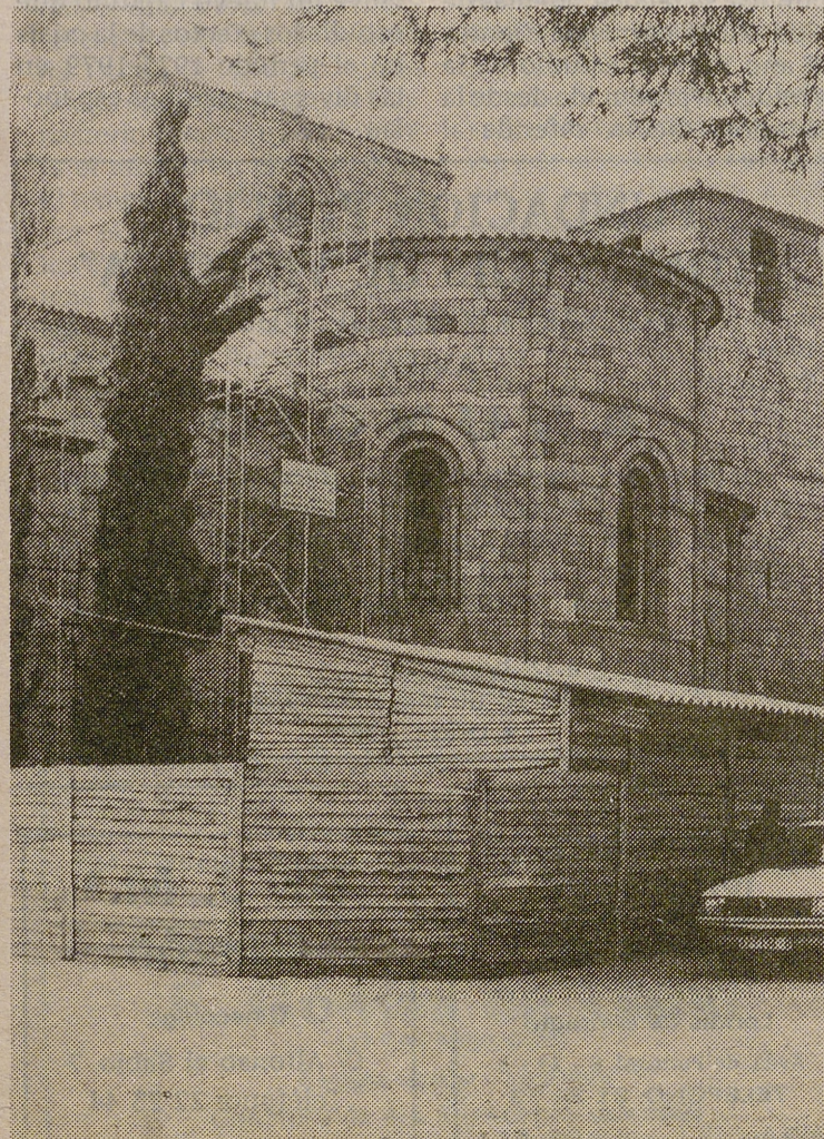
Iglesia de San Pedro: obras en el ábside, torre y crucero.
