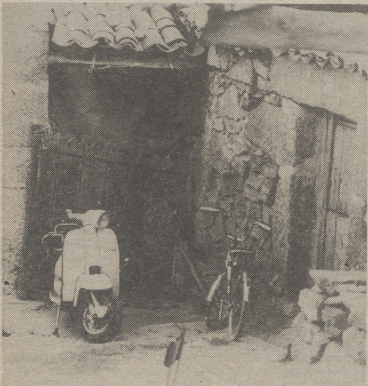
Esta puerta, cerrada con un candado, es el problema. Por ella debe pasar la conducción (según el proyecto mostrado a EL DIARIO DE AVILA), pero las propietarias se niegan al paso (afirman que el proyecto inicia fue reformado). En tiempos —nos dijo alguien en el pueblo— eso fue un callejón público.
