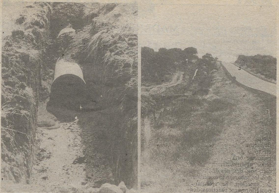
momento en que la tubería esté instalada en su totalidad se harán las pruebas de presión y una vez comprobado su buen funcionamiento llevará el agua a los depósitos. Mientras tanto, y con la ame-
