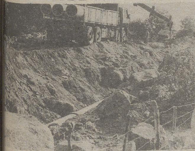
La colocación de la tubería que conducirá el agua desde la presa del Voltoya a nuestra capital avanza a un ritmo satisfactorio. La tubería colocada se encuentra ya a mitad del camino entre Vicolozano y Avila. Mientras se van colocando los tubos en la trinchera abierta, dos grandes máquinas van por delante abriendo la zanja que falta. Así que en muy poco tiempo la conducción esté completamente instalada y lista para entrar en servicio. Información en pág. 5.
