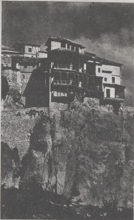
Las "casas colgadas" de Cuenca, sobre los ríos Júcar y Huécar. Cuenca y sus alrededores (la Ciudad Encantada, con curiosas formaciones naturales) atraen aún al turista por su ambiente y saber de vetustez, que necesitan de constante atención oficial frente al deterioro y la especulación inmobiliaria.
