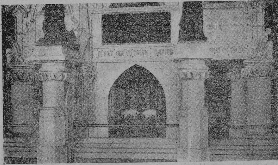
Parte inferior de la tumba de Colón, en la Catedral de Santo Domingo. La urna que guarda los restos está en el centro
