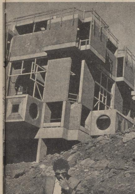
Uno de los elementos básicos de la construcción de «Arcosanti»: una estructura cuadrangular destinada a soportar otras estructuras de gran peso.
