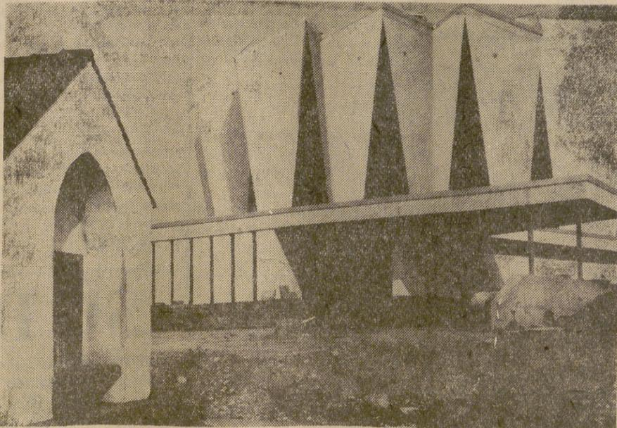
gótico, en una técnica moderna. Soportes principales de la nave de cúpula, de 28 metros de altura, lo son pilones de elementos prefabricados, cuyos intersticios elevados fueron tapados con ventanas de cristal de color.
