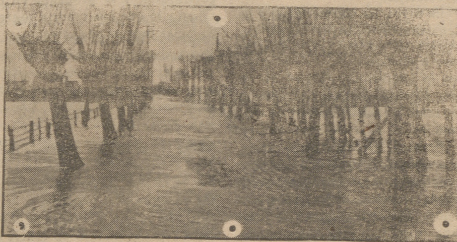
Una fotografía de una zona de los Países Bajos sometida a una inundación provocada por los alemanes.—(Foto «Presamundo»).
