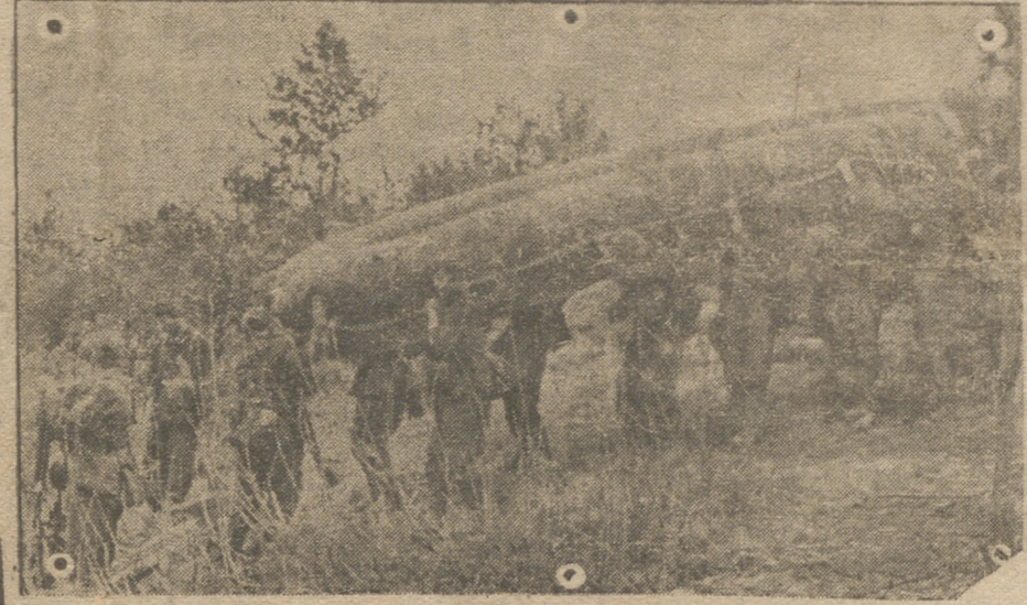
En el sector central del frente del Este, una compañía de zapadores pone en servicio un bote neumático para atravesar un río que todavía no está helado (Foto «Presamando»)
