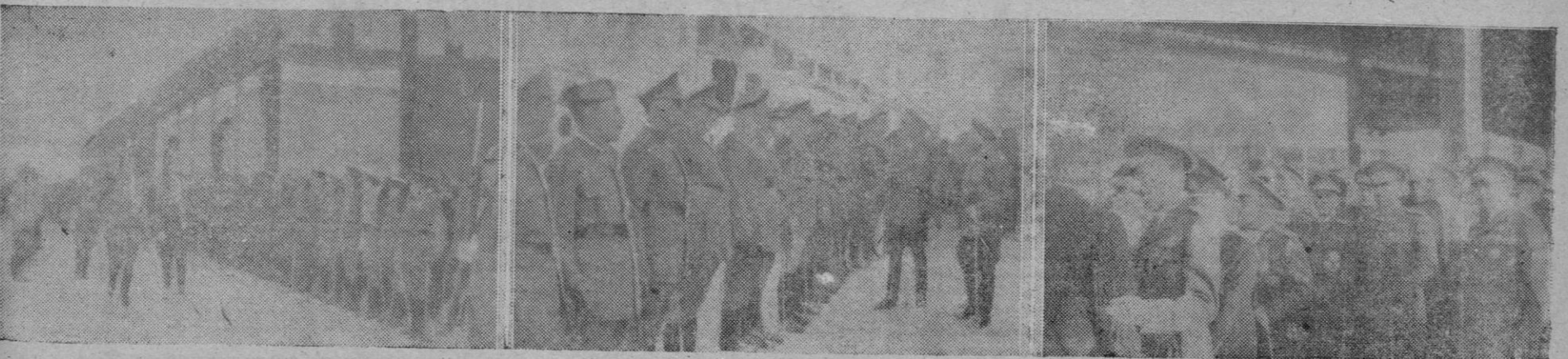
1.º S. E. pasa revista a la Compañía que le rindió los honores reglamentarios. — 2.º El general Asensio saluda a los Jefes de guarnición y 3.º El nuevo Capitán General conversando con el Ingeniero Director de la Junta de Obras del Puerto señor Roca. Fotos Ribas de Duran
