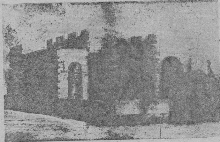
Aspecto parcial de las obras del nuevo templo
