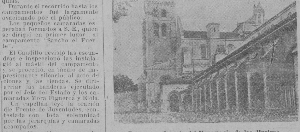
Burgos. — Aspecto del Monasterio de las Huelgas
