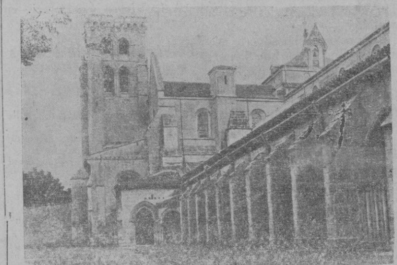
Burgos. — Aspecto del Monasterio de las Huelgas
