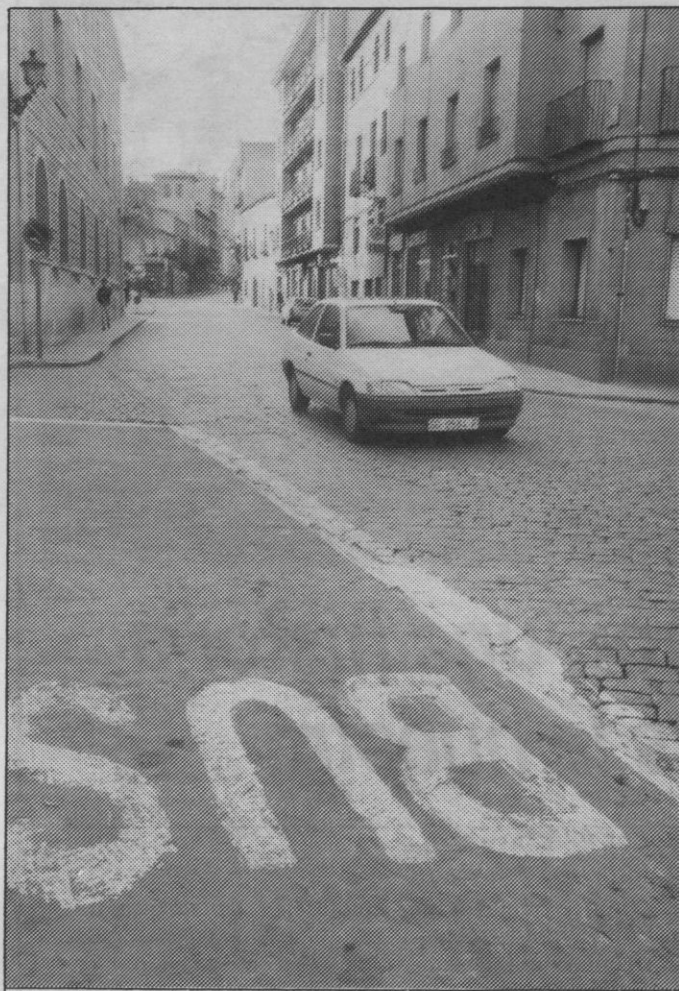
El mal estado del adoquinado de la zona perjudica al tráfico.
