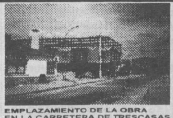
EMPLAZAMIENTO DE LA OBRA EN LA CARRETERA DE TRECASCAS
