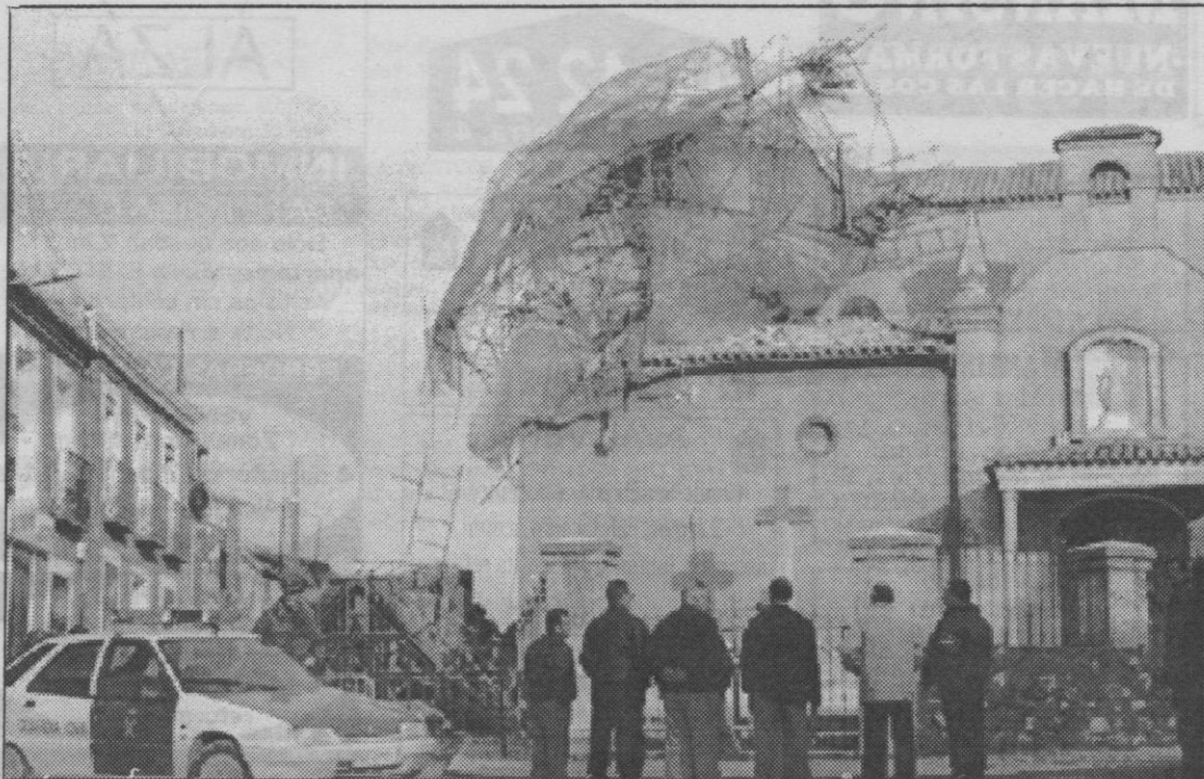
La torre del tiempo, de origen mudéjar, estaba en proceso de restauración.
