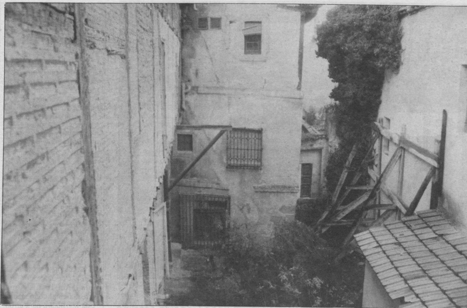
Las obras del Ayuntamiento en el barrio judío recuperarán para la ciudad el llamado callejón de Santa Ana.
