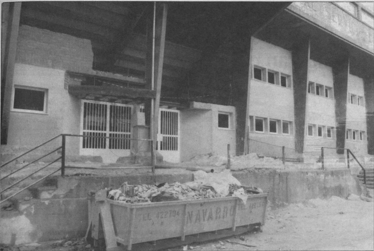
Las obras del pabellón de pelota a buen ritmo.
