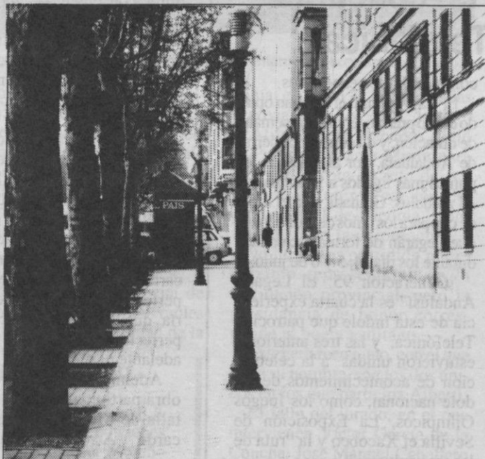
El cableado subterráneo se va generalizando.
