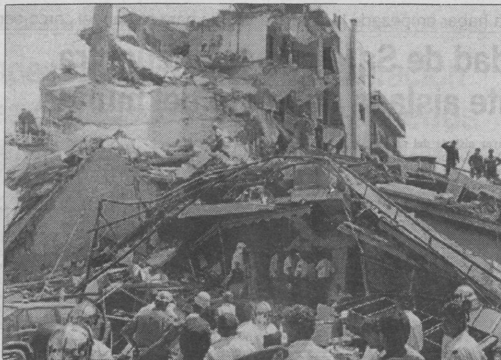
Los equipos de rescate buscan supervivientes entre los escombros del edificio derrumbado.
