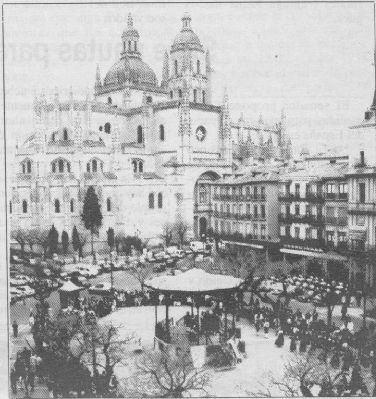
La actuación abordará la mejora de los edificios. JUAN MARTIN
