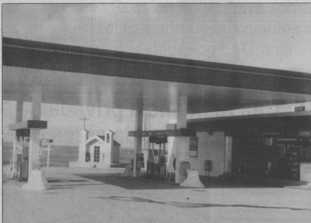
La capilla está situada junto a la estación de servicio del mismo nombre.
