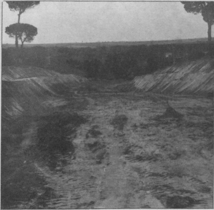
Obras de acometida del viejo puente sobre el río Voltoya.
