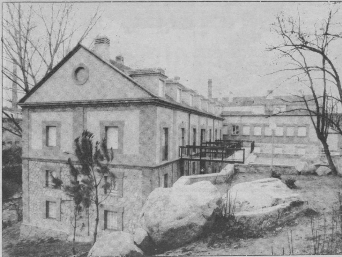
Las viviendas de Carretero están prácticamente finalizadas.
