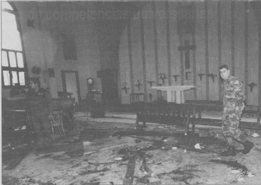
Soldados libaneses examinan los daños tras la explosión de una bomba en una iglesia de Beirut.
