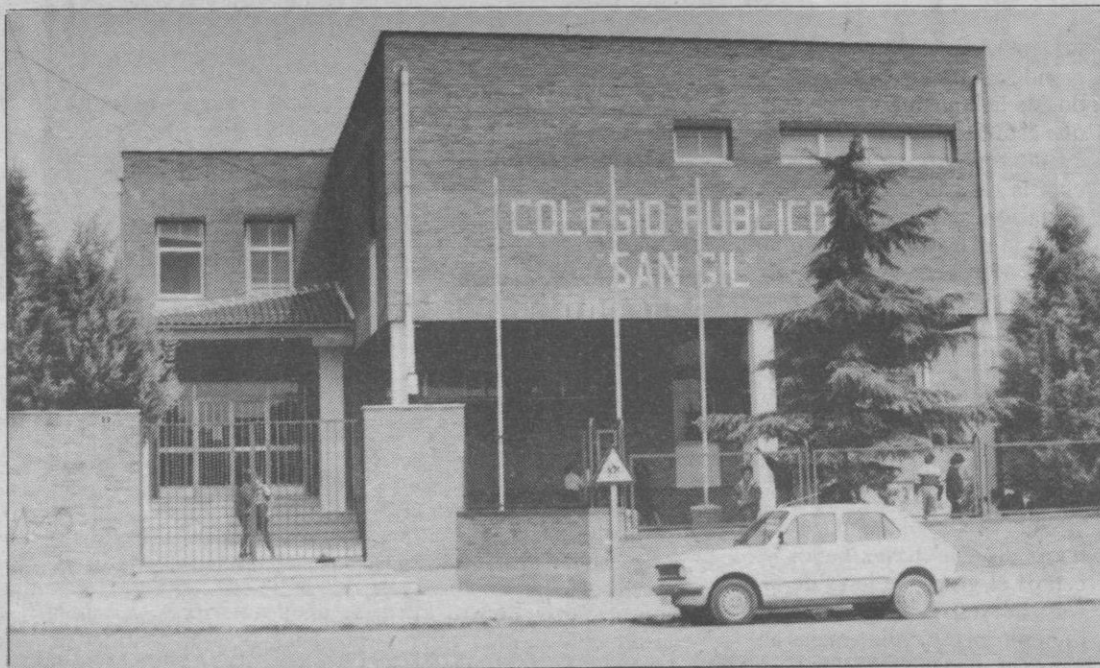
Fachada del colegio público San Gil, uno de los tres centros escolares que abren hoy sus puertas. S.G.
