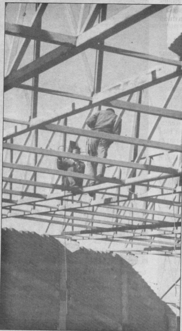
Entre enero y marzo sólo trabajan dos soldadores.
