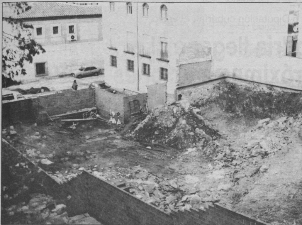
El alcalde reconoce que hubo "incorrección" en el inicio de las obras de la calle La Parra. PEÑALOSA
