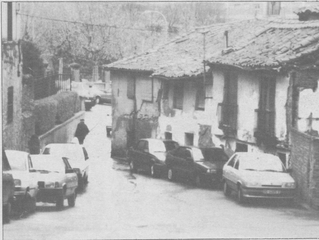
Este estrechamiento en Machado podría salvarse con el acuerdo de los propietarios de la casa.
