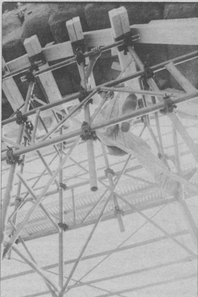
Las cimbras pretenden evitar cualquier desprendimiento.
