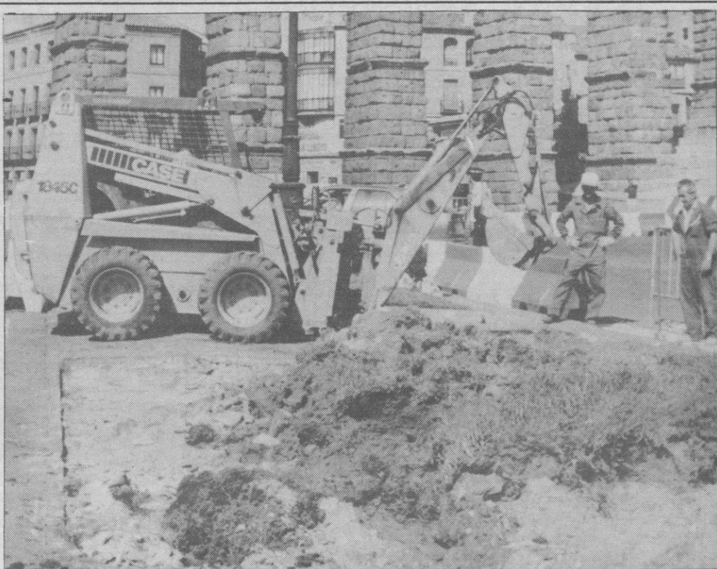
Una máquina excavadora trabajaba hoy para quitar los setos de la Plaza de la Artillería.
