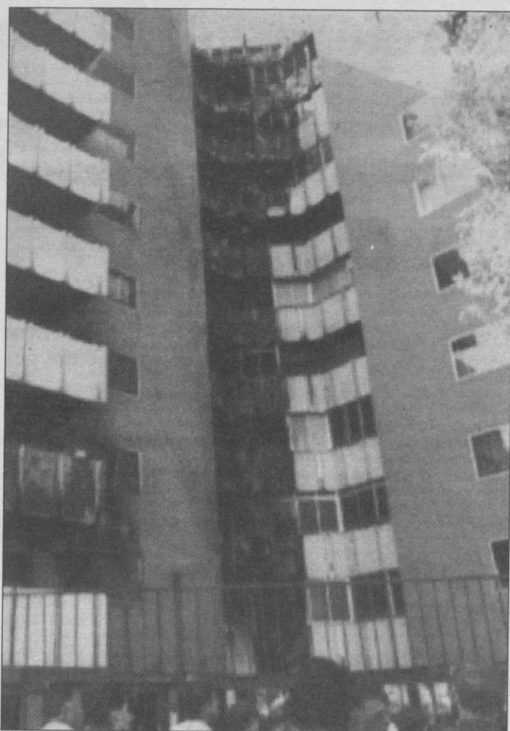
El edificio de 10 pisos después del incendio.
