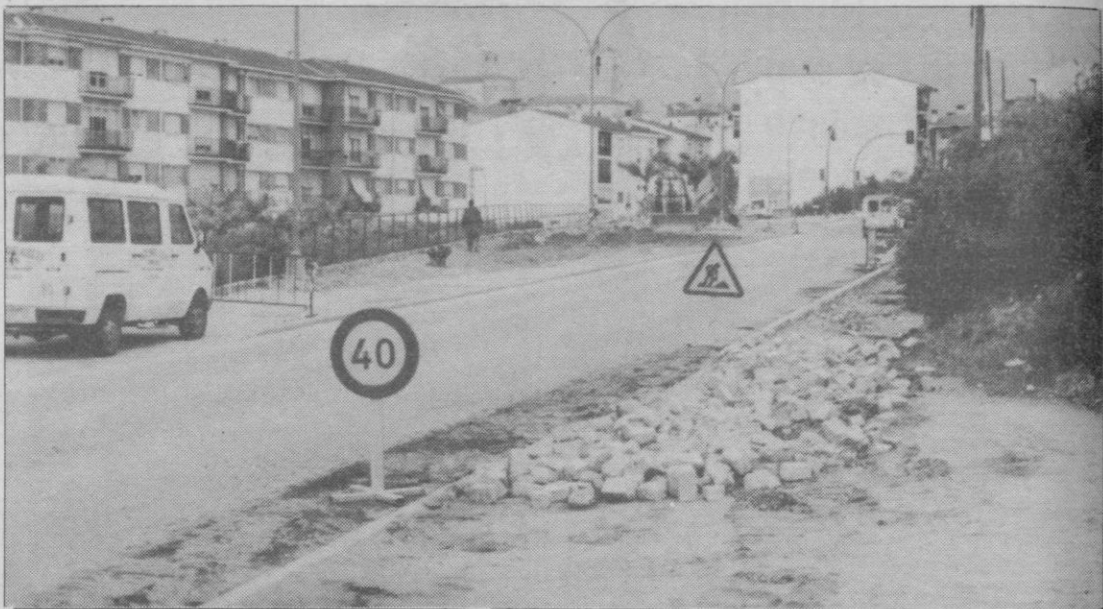
Las obras han comenzado con el levantamiento de las aceras.
