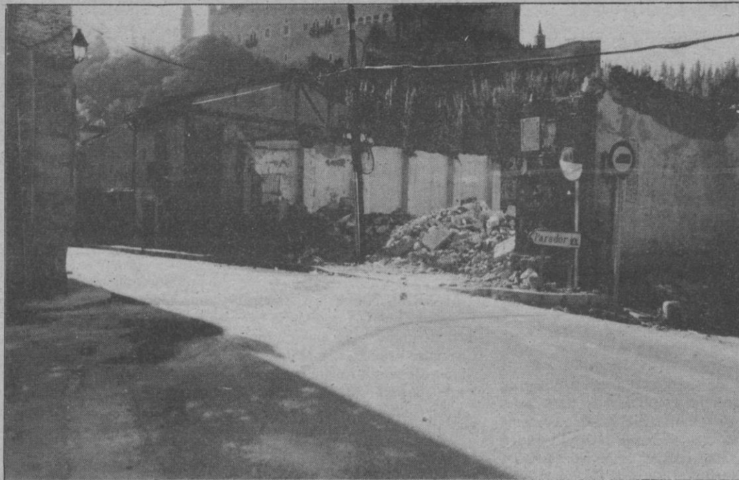
El cruce de San Marcos, un punto especialmente peligroso. Al fondo el edificio derruido
