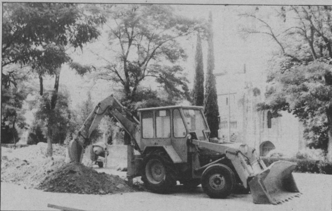
Una excavadora trabaja en la plaza de Colmenares
