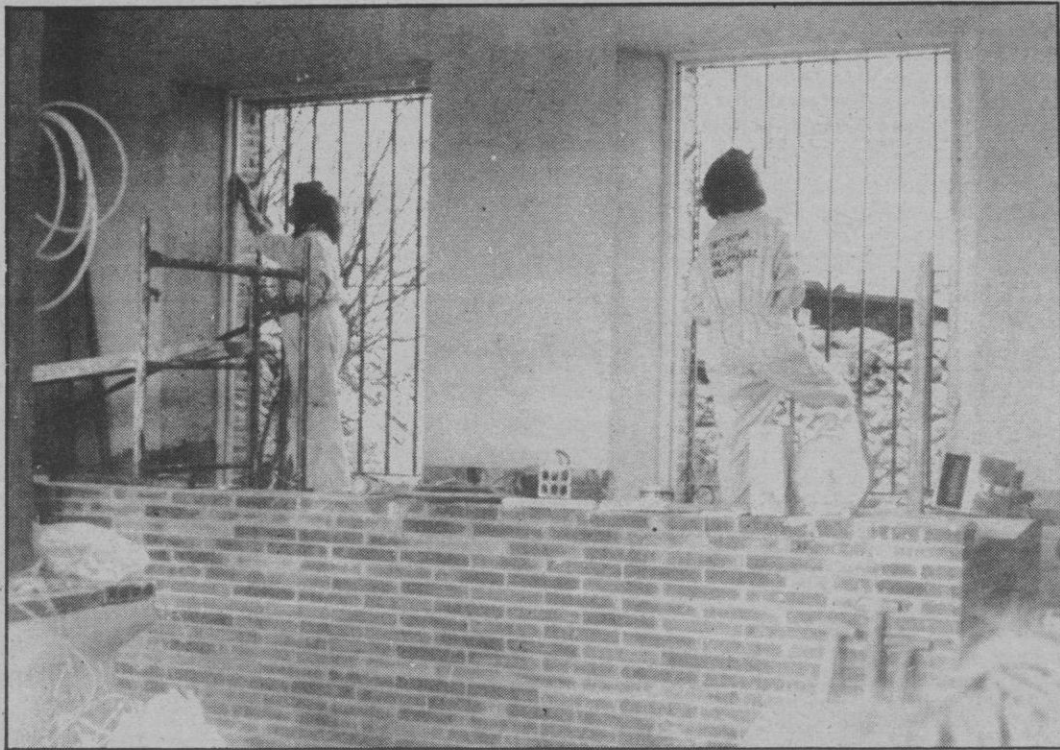
Chicas de la Escuela Taller durante las obras
