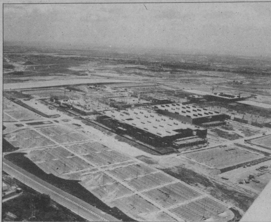
La foto, tomada en los primeros días del mes de mayo, muestra casi finalizada la fachada sur —la principal— del Nuevo Recinto. Los Pabellones 1 —izquierda— y 2 —derecha— y el Edificio Central de oficinas, están cubiertos. Este edificio, en los momentos en que publicamos esta edición, ya tiene completo su exterior y se trabaja en los sótanos —área de congresos— y en el gran patio central. Delante se ve parte de la urbanización —ya en un 95% concluida— y algunas de las 12.000 plazas de aparcamiento existentes
