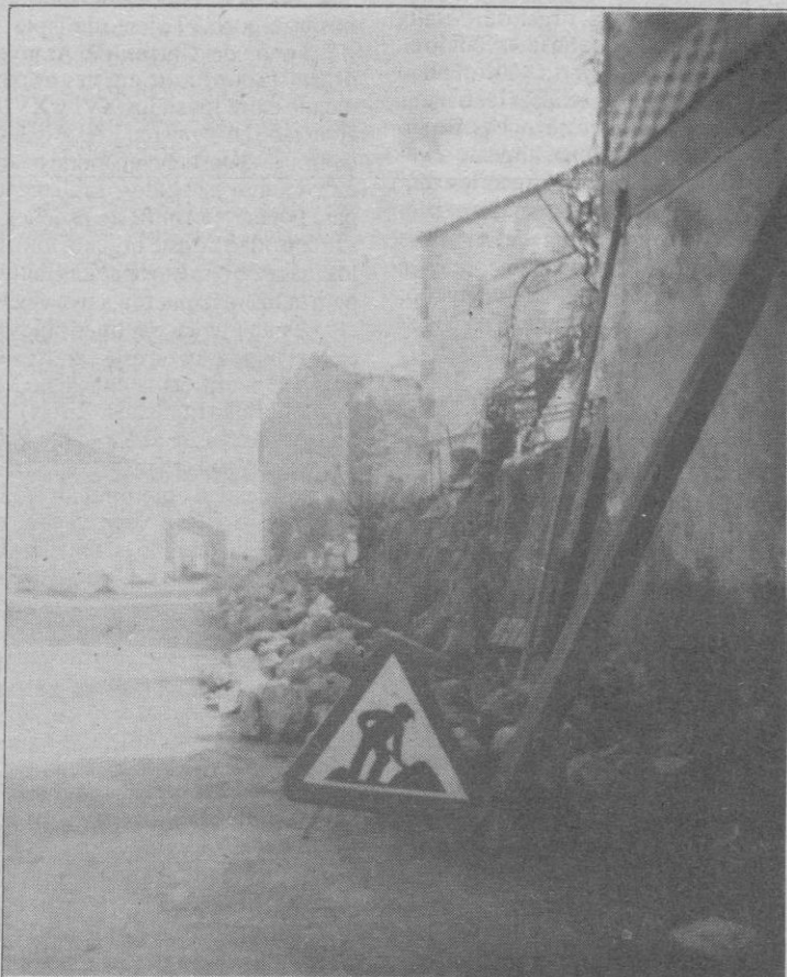
Calle en obras donde tendrá lugar la repoblación.—(Foto: Juan Carlos)
