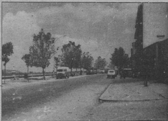
La N-601 en el tramo inmediato a la plaza Oriental, también comprendido en las obras proyectadas por el MOPU
