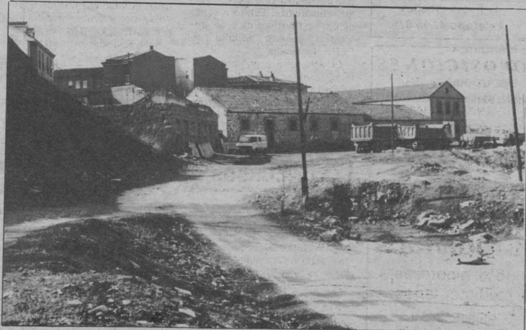
ZONA EN MAL ESTADO
