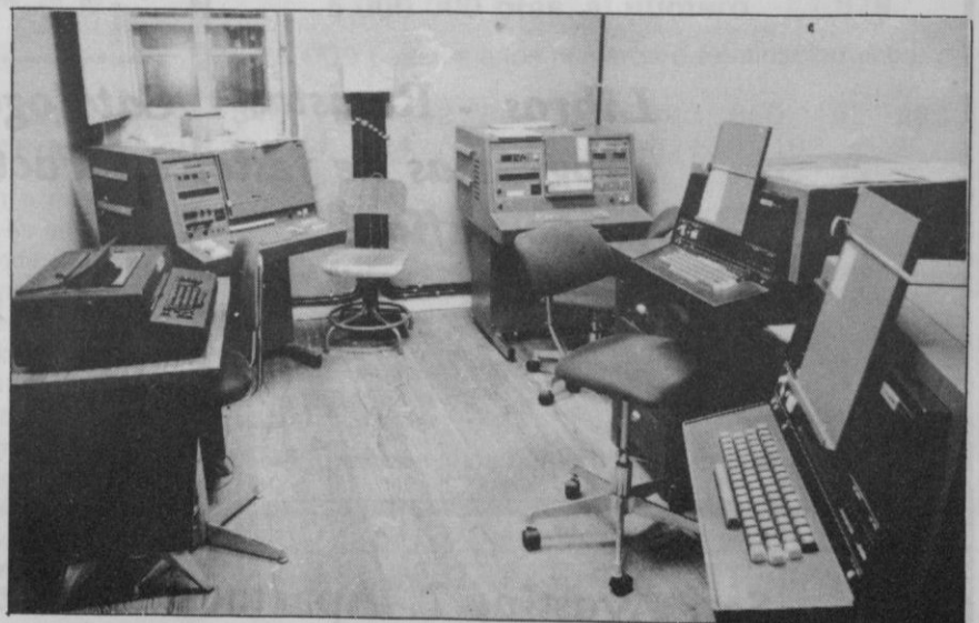
Las nuevas máquinas por el sistema de fotocomposición, que alcanzan mucha mayor rapidez que las linotipias y que son las que hoy se utilizan para componer el texto del periódico.
