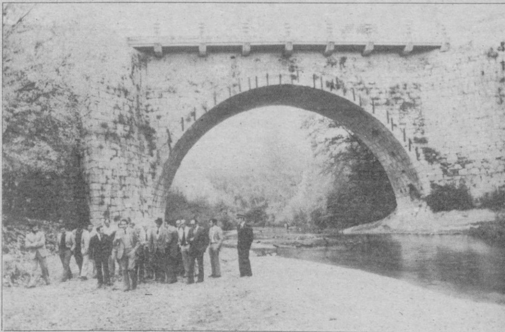
Ayer, bajo la presidencia de don Rafael de las Heras Mateo, presidente de la Diputación Provincial, se inauguraron los puentes de Coca y Allas sobre los ríos Eresma y Moros, respectivamente. En la fotografía, el puente de Coca.—(Foto: Aurelio M.)
