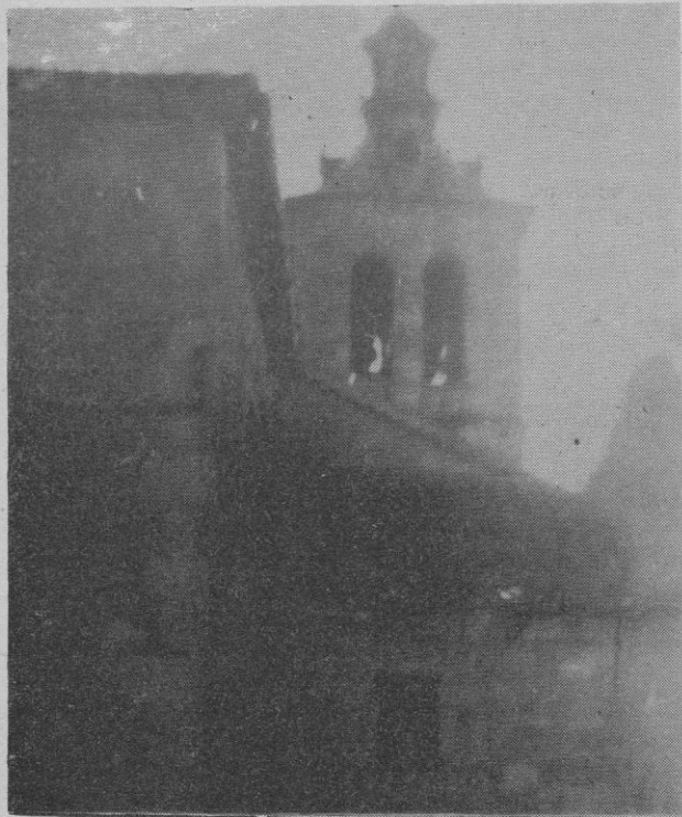
La humareda impide ver con nitidez los daños causados en el chapitel. (Foto Nicéforo)
