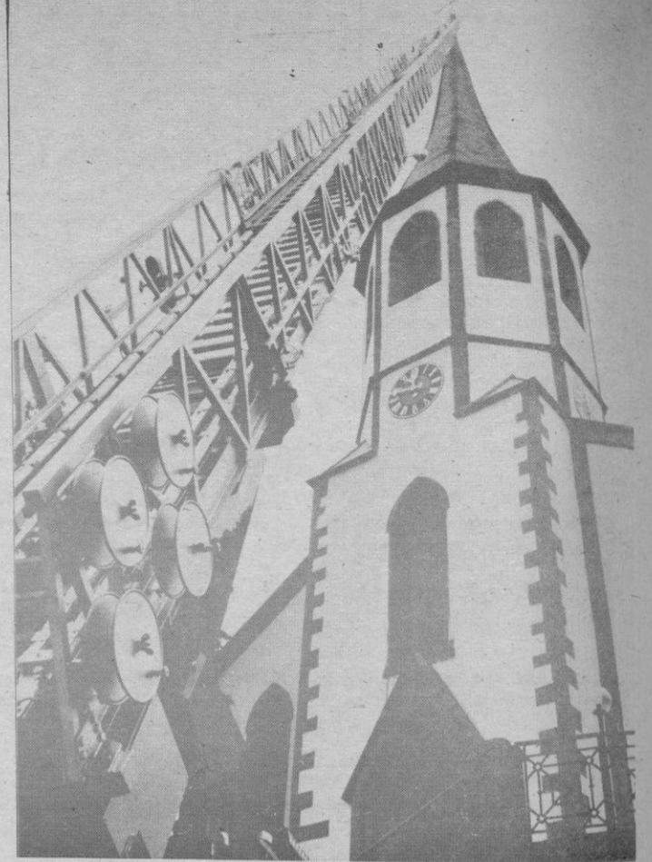
Karlsruhe.- La mayor escalera giratoria de bomberos jamás construida acaba de ser fabricada por una empresa de Karlsruhe especializada en la construcción de toda clase de escaleras móviles. Es hidráulica y mide nada menos que 53 metros de altura. La fabricación de este tipo de escalera dura casi doce meses, y de ahí que no sea de extrañar su precio de 650.000 marcos. Esta empresa alemana exporta escaleras de bomberos a todos los países del mundo. (Foto DaD - Infoto)
