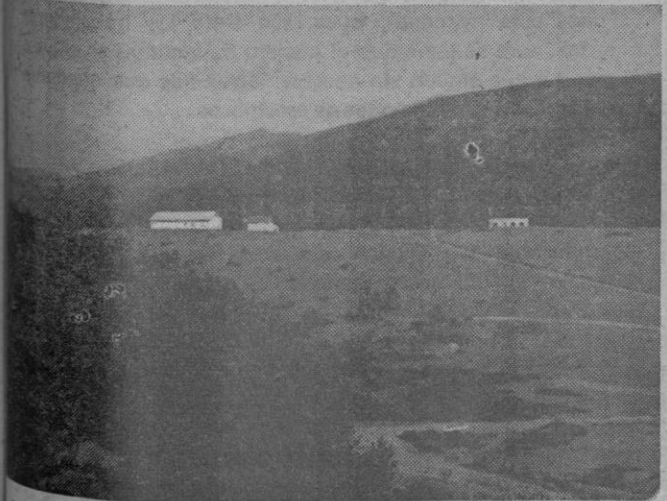
Puerto de Cotos. Al fondo, a la derecha, el edificio que será albergue de la D. A. S.
