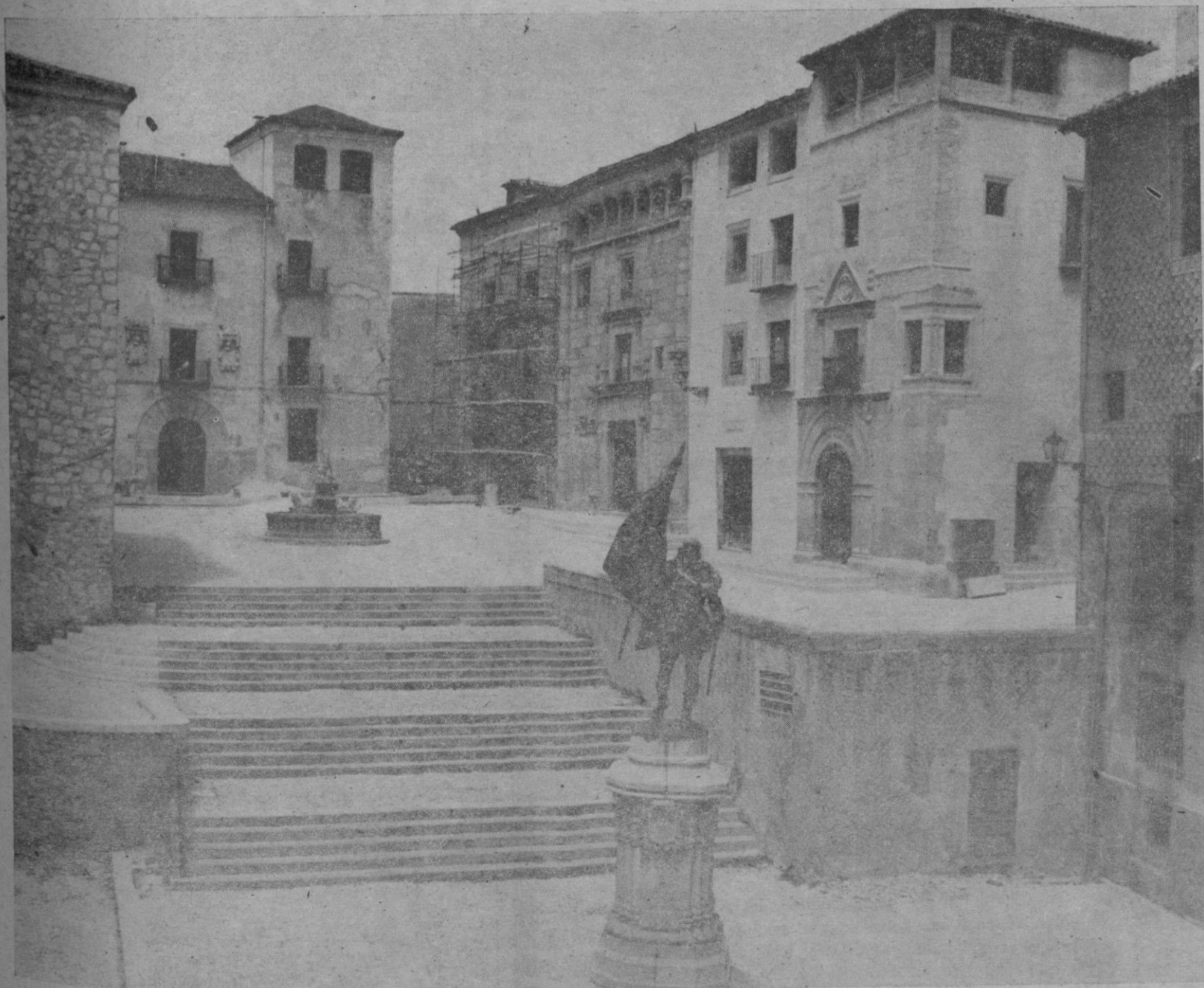
La iglesia de San Martín en la plaza de Las Sirenas. Esta foto fue tomada durante la reciente restauración de las fachadas de este excepcional conjunto urbano
