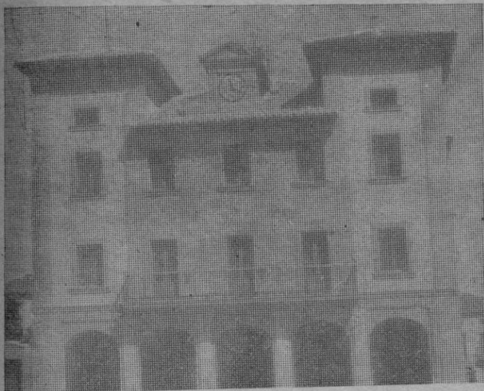
Fachada principal del Ayuntamiento.—(Foto Núñez)
