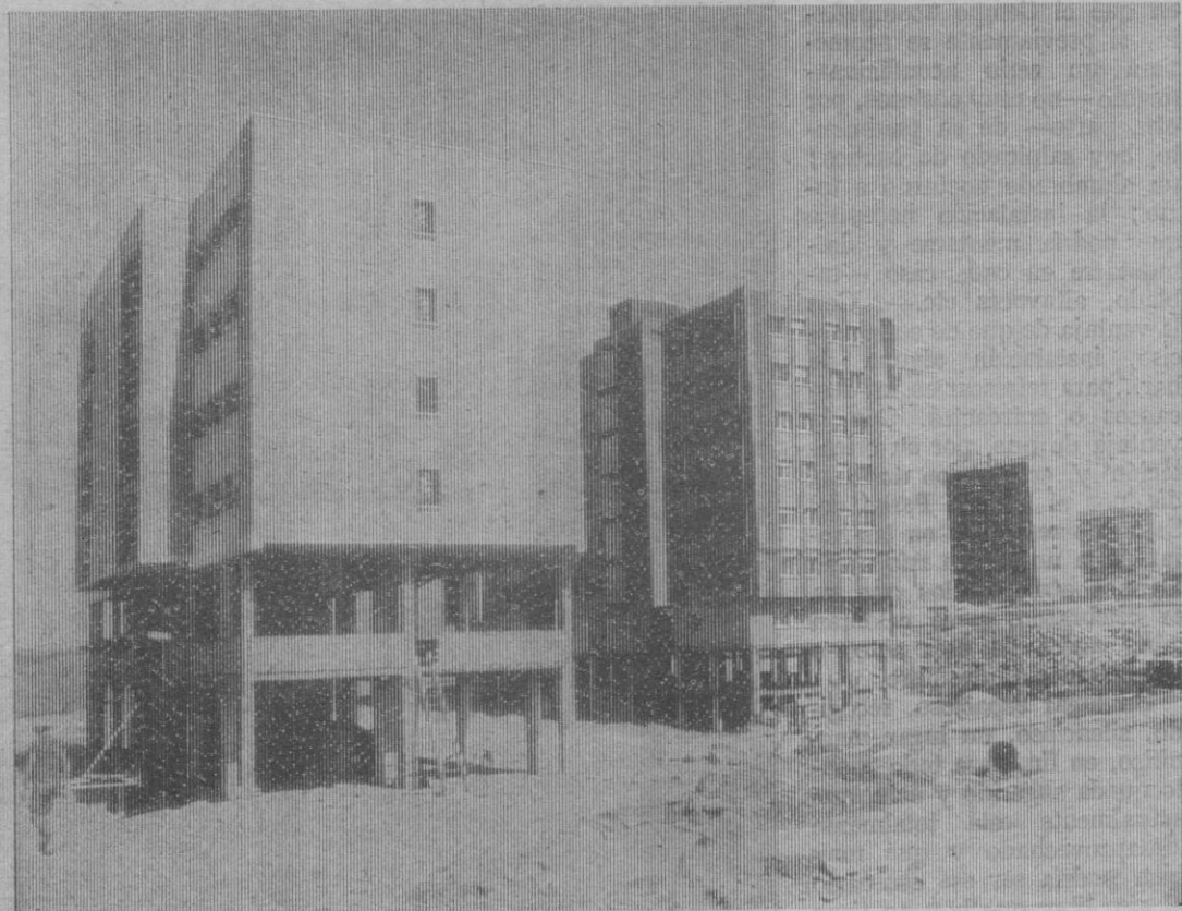
Los edificios tienen una cierta variedad, distintas alturas y coloridos
