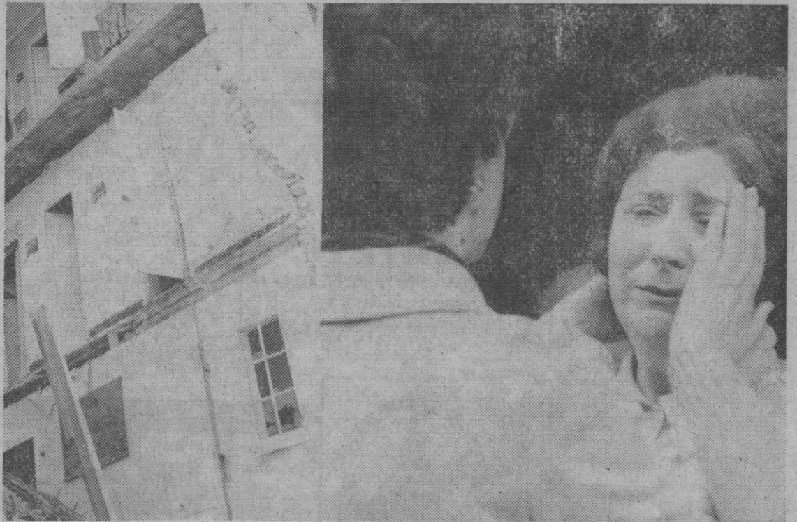
Barcelona.—Dos edificios sitos en la calle de Ladrilleros, del barrio de Sans, sufrieron una pavorosa explosión, al parecer a causa del gas. El suceso ha llenado de dolor y consternación al barrio de Sans y hasta el momento se han retirado 11 muertos y 18 heridos entre los escombros y no se descarta la posibilidad de que existan aún personas sepultadas.—(Foto Europa Press).
