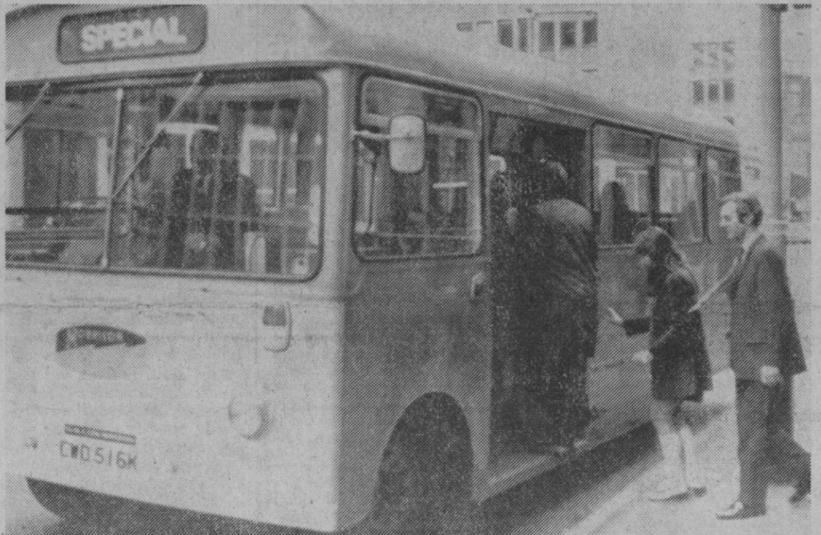
Londres.—Este es uno de los dos autobuses propulsados por energía eléctrica que realizan pruebas actualmente en la capital, los cuales serán capaces de recorrer 56 kilómetros sin interrupción, entre el tráfico congestionado, y 112 kilómetros en caso de no parar. Después de varias pruebas en otras ciudades y si éstas resultasen satisfactorias, entrarían en servicio, con las consiguientes ventajas de escaso ruido y ninguna contaminación sobre el medio.—(Telefoto AP-Europa Press)
